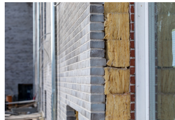
20 centimeter isolering og en ny mursten uden på de gamle røde mursten.
