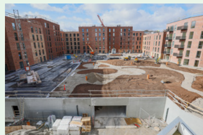
Under hele bebyggelsen i Brokvarteret er der parkeringskælder.
