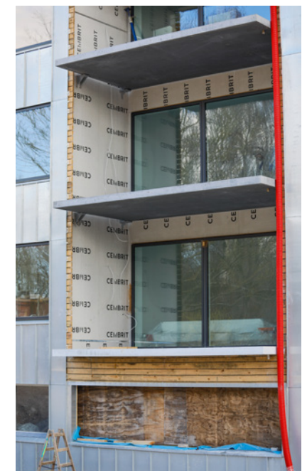
I forhold til tidligere rækker Kærgårdsparkens nye altaner en meter længere ud.
